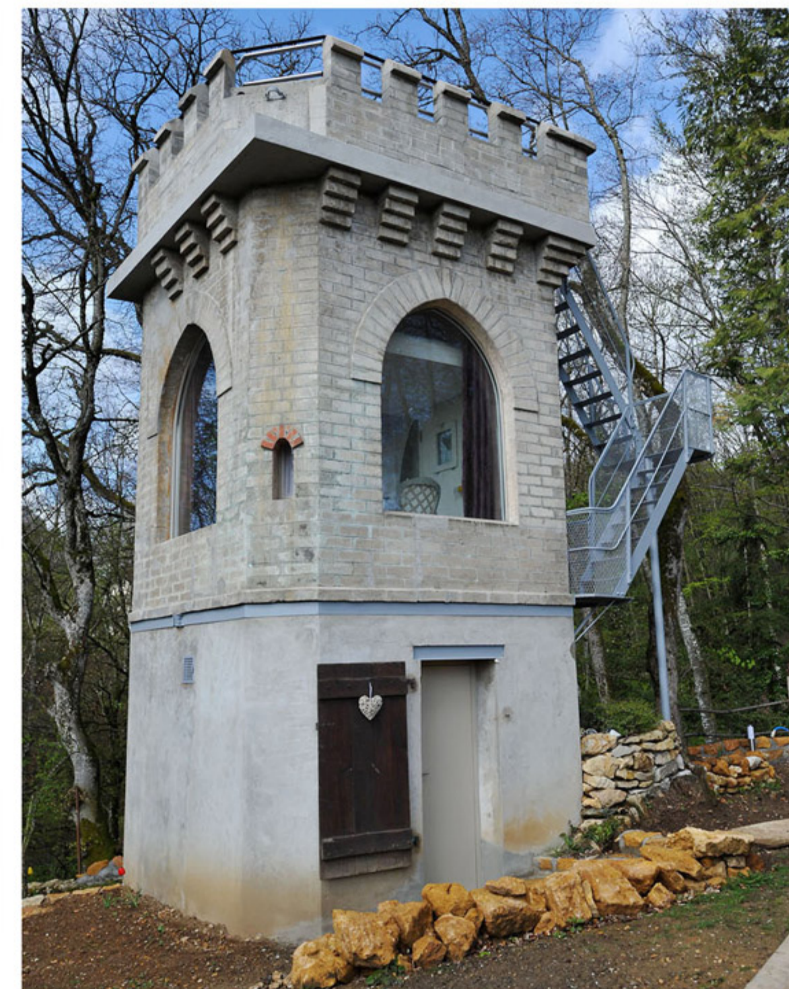
L'édifice a été bâti en 1900 pour observer les oiseaux. RICHARD LEUENBERGER
